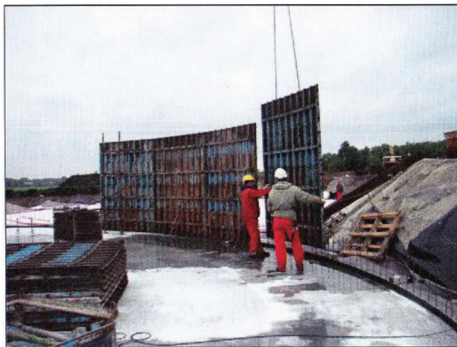
2. Aufstellung der Betonschalung
