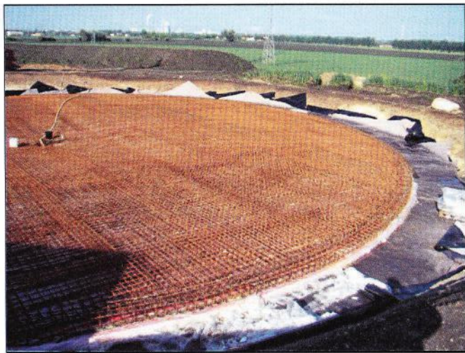
1. Herstellung der Grundplatte
