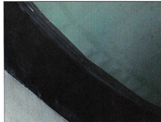
8. Dämmung mit Gasschutzmatte
